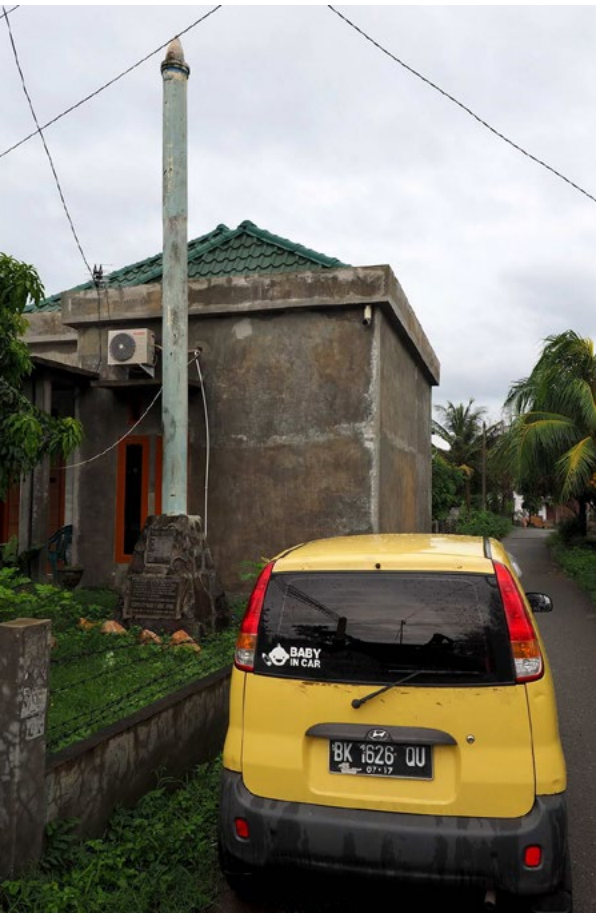
Tingginya gelombang tsunami diabadikan pada sebuah tiang di daerah Deah Baro, Banda Aceh. Ujung tiang adalah tingginya permukaan gelombang tsunami yang melanda daerah itu pada 2004.
